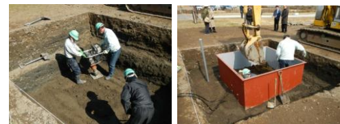
試験施工の様子
