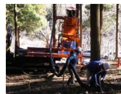
バキューム装置を用いた作業の様子
