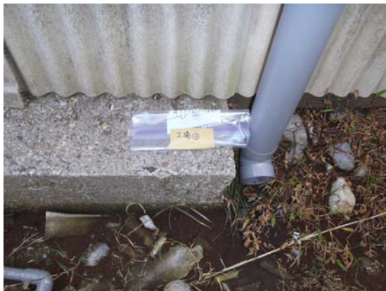
図3(1) 縦樋の下の土壌での濃集(蓄積)
