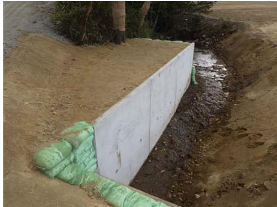
図-4.3 擁壁設置状況（渓流水による浸食防止対策）
