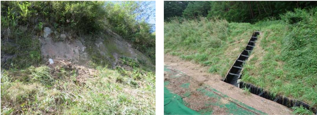
図-3.1 切土法面の崩れ・縦排水路の損傷
