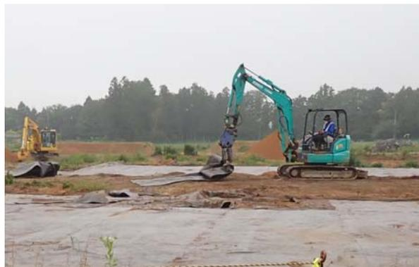
図-4.1 下部シート保護マットの撤去
