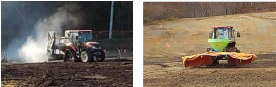
図-4.5 土壌改良材の散布・種子の散布
