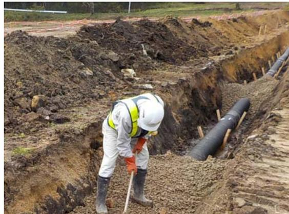
図-4.4 暗渠管の設置
