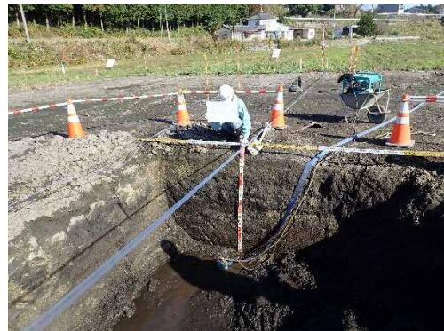
浸出水集水設備掘削壁面状況
