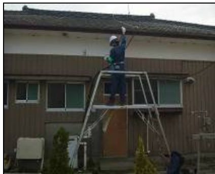
屋根表面の詳細測定
