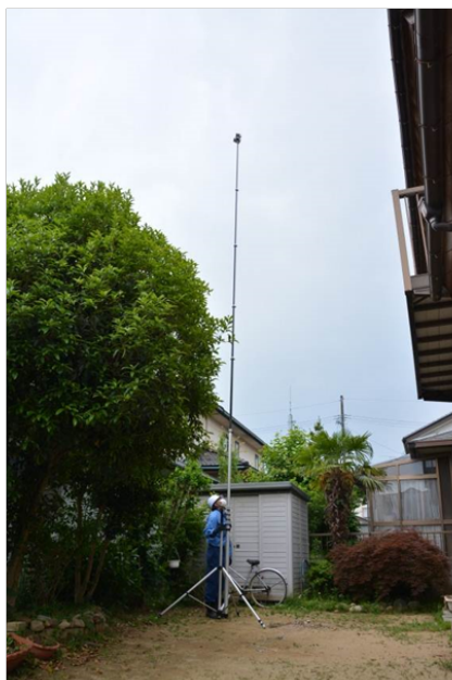
①-1 高所点検カメラによる状況確認
