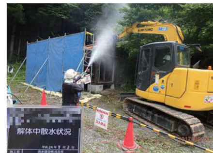
被災家屋等の解体の様子
