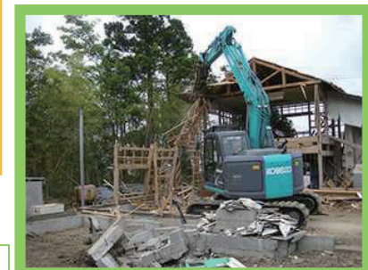
被災家屋等の解体
