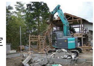
被災家屋等の解体
