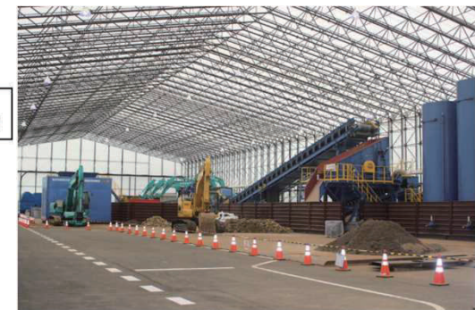
受入・分別施設(大熊1期②工区)
