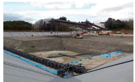
土壌貯蔵施設(双葉1期①工区)
