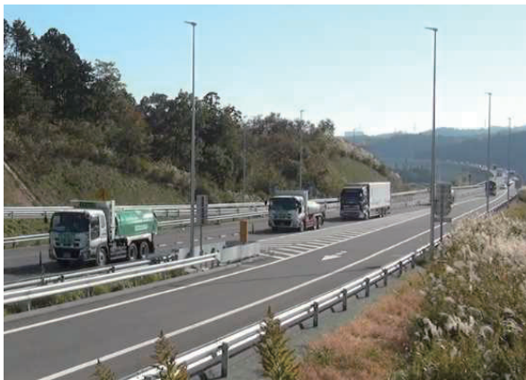
常磐自動車道走行状況(ならばPA付近)
