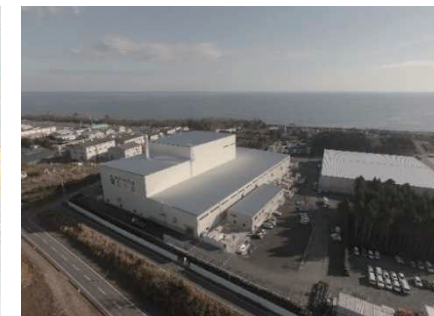
大熊町の仮設焼却施設
