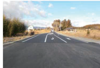
舗装厚改良工事後の道路の様子(県道251号線)
