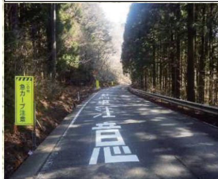
A箇所(路面標示、看板設置)
