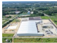
不燃性廃棄物再資源化施設
