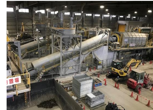
受入・分別施設(大熊①工区)
