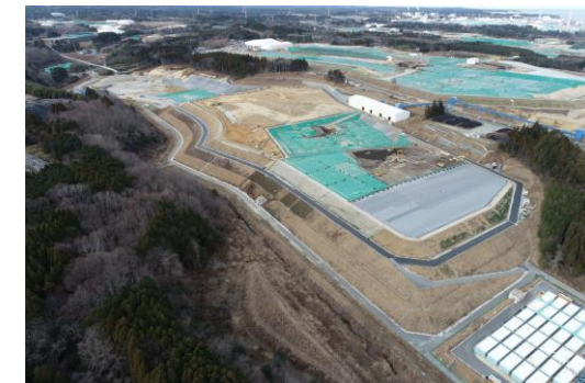
土壌貯蔵施設(大熊③工区)
