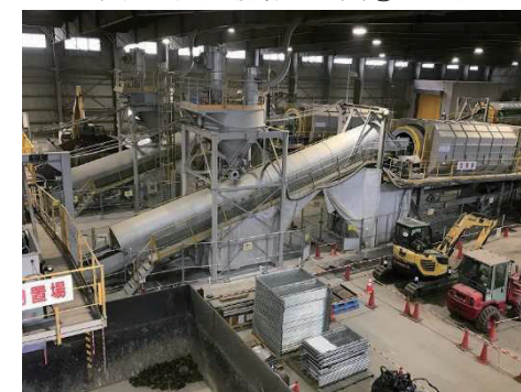
受入・分別施設(大熊①工区)
