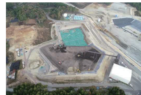
土壌貯蔵施設(双葉①工区)
