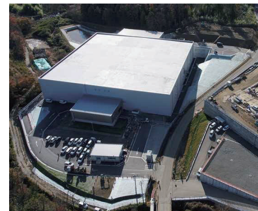
廃棄物貯蔵施設(双葉1工区)
