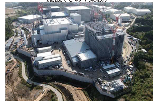
双葉町仮設焼却施設及び仮設灰処理施設(その1業務)
