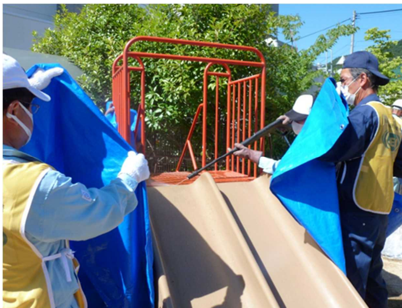
図 2-17 遊具の除染の例（高圧水洗浄）
