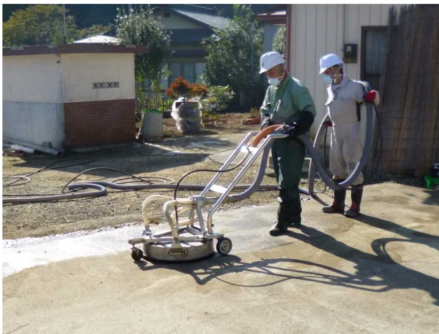
図 2-37 舗装面の除染の例（回収型高圧水洗浄）
