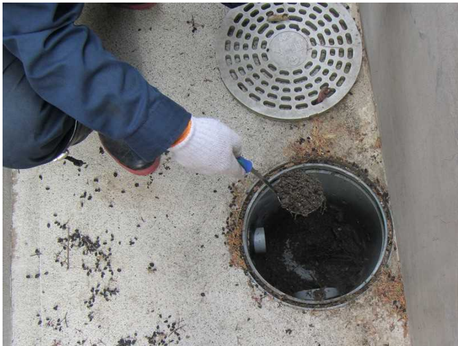
図 2-24 雨水枡の除染の例（堆積物の除去）
