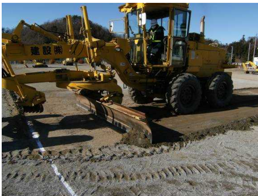
図 2-50 校庭の除染の例（表土の削り取り）
