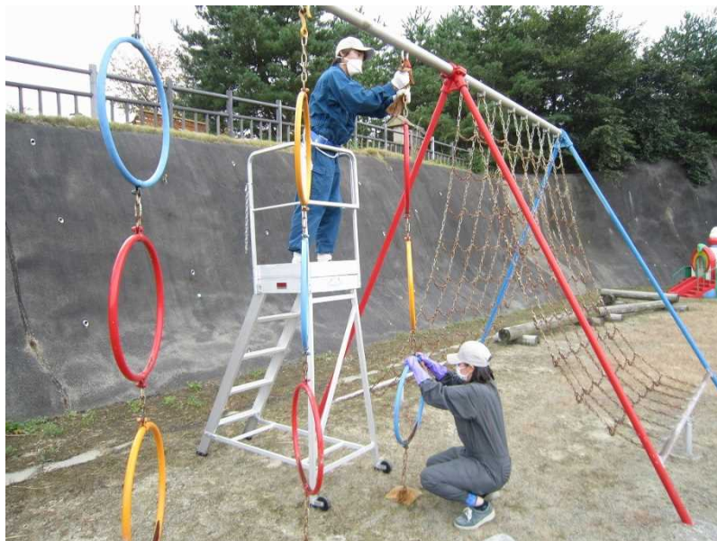
図 2-16 遊具の除染の例（拭き取り）
