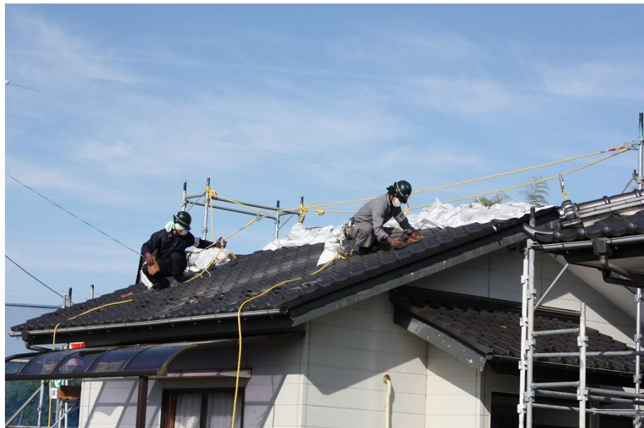
図2-9 屋根の瓦の除染の例（拭き取り）
