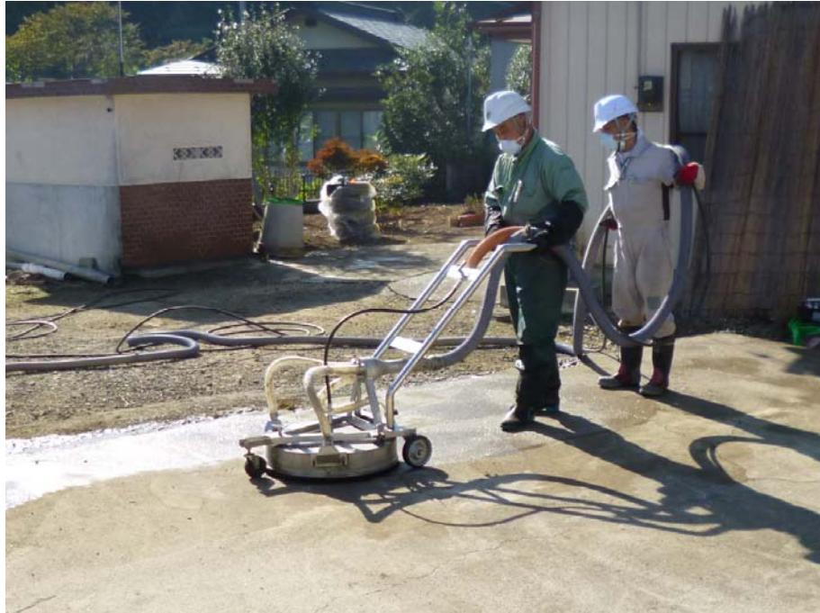
図 2-37 舗装面の除染の例（回収型高压水洗浄）
