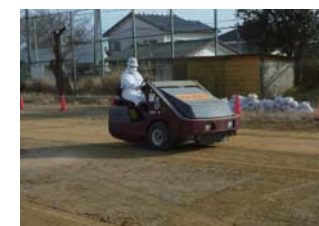
グラウンド 表土はぎ取り
