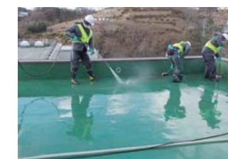
構造物 高圧水洗浄
