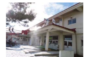
構造物 屋根清掃(高圧水洗浄)
