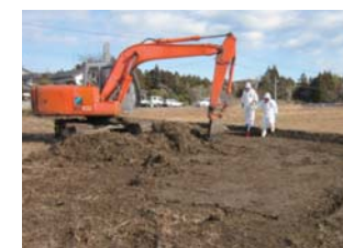
農地 表土はぎ取り
