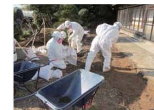
宅地 表土はぎ取り
