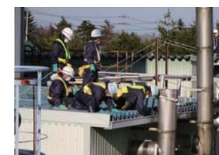
構造物 雨どい内の除染
