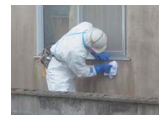
宅地 壁の除染
