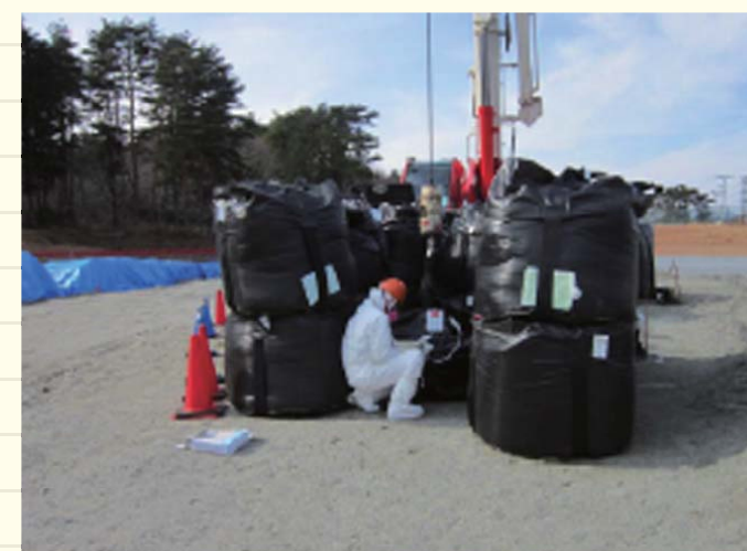
除去物の表面線量率測定状況
