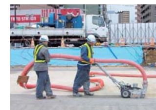
道路 表面削り取り
