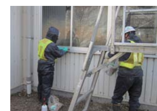
構造物 窓・サッシ周りの湿式ブラシ洗浄と拭き取り
