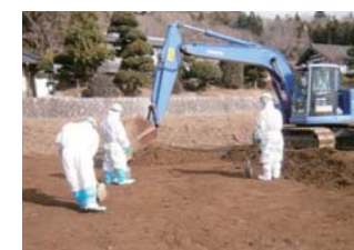
農地 表土はぎ取り
