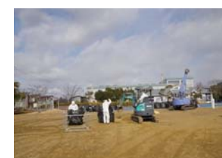
グラウンド 表土はぎ取り
