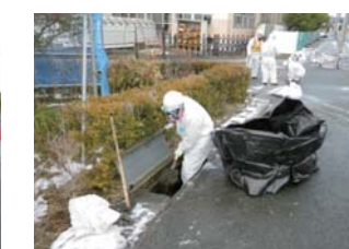
雨水枡・側溝 土砂払い
