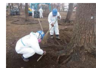
街路樹 表土はぎ取り
