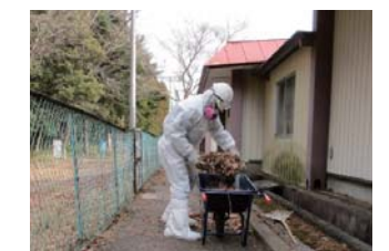
雨水枡・側溝 側溝等のホットスポットの除染
