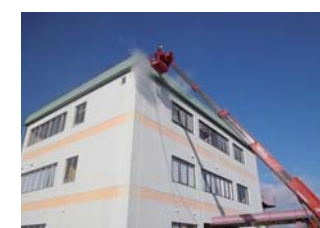
構造物 屋根・壁面清掃(温水洗浄)
