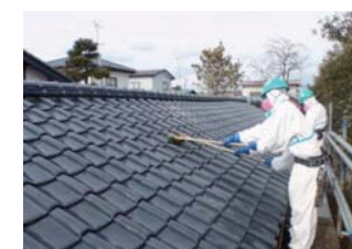
宅地 屋根の除染
