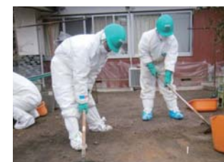
宅地 表土はぎ取り
