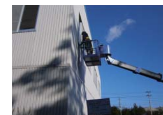
構造物 建屋の窓・サッシ周りの除染
