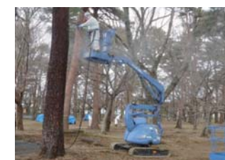
街路樹 高圧水洗浄(高所作業車)
