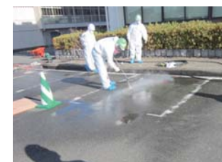
駐車場 高圧洗浄機による洗浄
