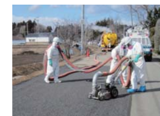
道路 超高压洗浄機による車道洗浄
