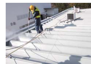
構造物 屋根部の洗浄
