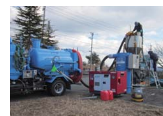
森林 バキューム車による落葉、リター層除去
