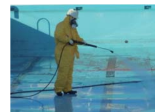
プール 高圧洗浄機による洗浄
