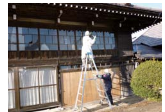
宅地 壁面清掃
