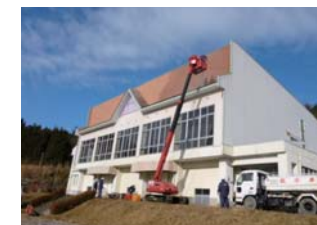
構造物 壁面清掃
