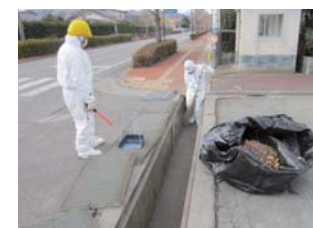
側溝 側溝清掃
