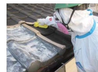
宅地 手拭きによる屋根の除染
