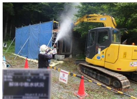
被災家屋等の解体の様子
