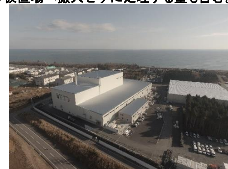
大熊町の仮設焼却施設
