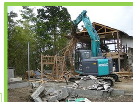
被災家屋等の解体
