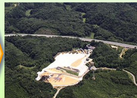
特定廃棄物埋立処分施設 (旧フクシマエコテッククリーンセンター)
