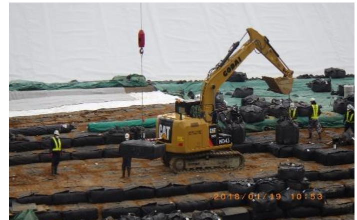
地盤改良用収納容器を埋め立てる様子
