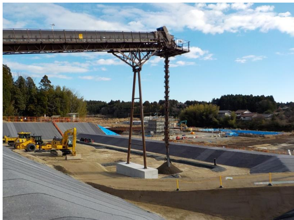
土壌貯蔵施設(1期双葉工区) (計画貯蔵容量 約4万m 3 )
