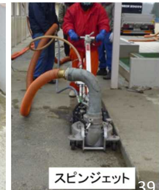
自走式高圧洗浄機による除染
