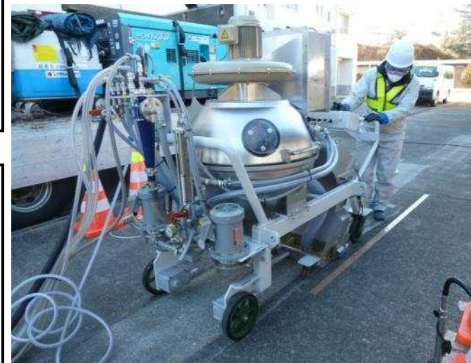
団地内舗装面の除染作業
