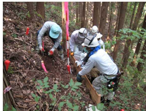
下草・落葉層の除去作業
