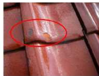
釉薬瓦 釉薬の剥がれた箇所
