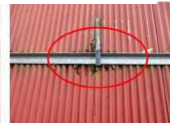
トタン 雪止め箇所
