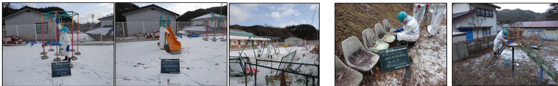
園庭A(年間積算線量約10mSvの区域内)の遊具の除染結果(拭き取り等による除染)
