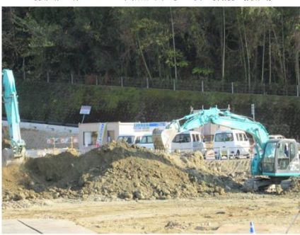
搬出区域における自然由来等土壌の掘削（搬出）
