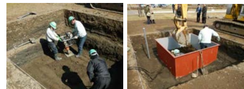
試験施工の様子
