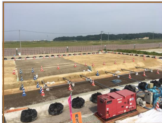
盛土施工状況(2層目)
