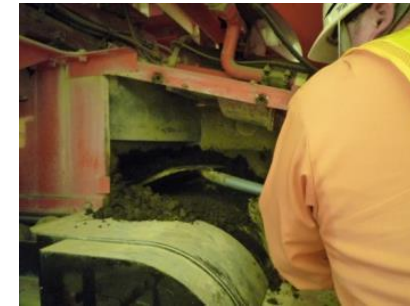
改質機土砂の排出作業状況
