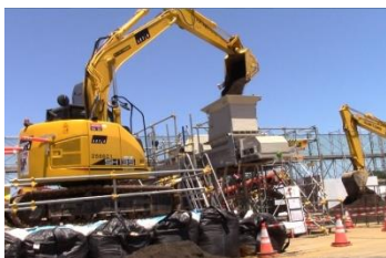
(ホッパーへの土壌投入状況)
