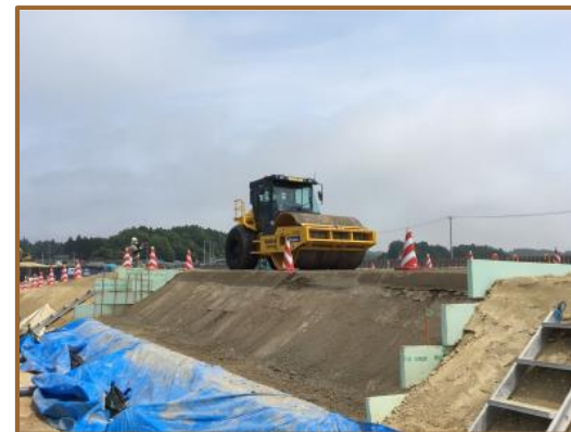
転圧状況(4層目)
