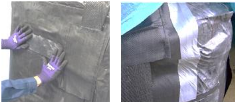
図 2.1.3-4 保管容器の補修
