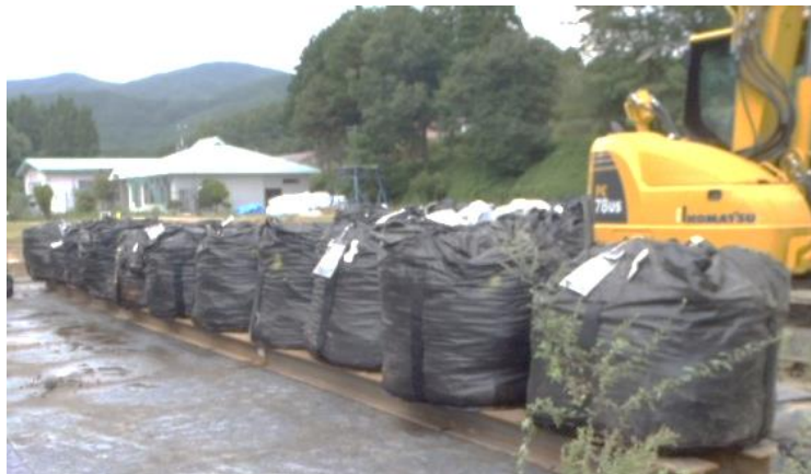
図 2.1.3-6 水切り架台の設置状況の例
