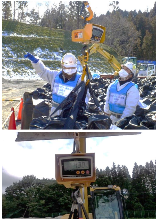
図 2.1.3-7 重量測定状況
