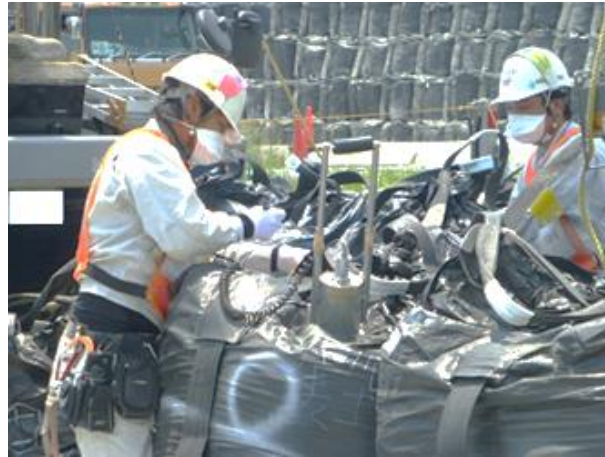
図 2.1.3-8 容器の表面線量率の測定状況
