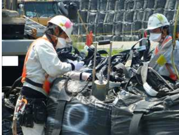
図 2.1.3-8 容器の表面線量率の測定状況
