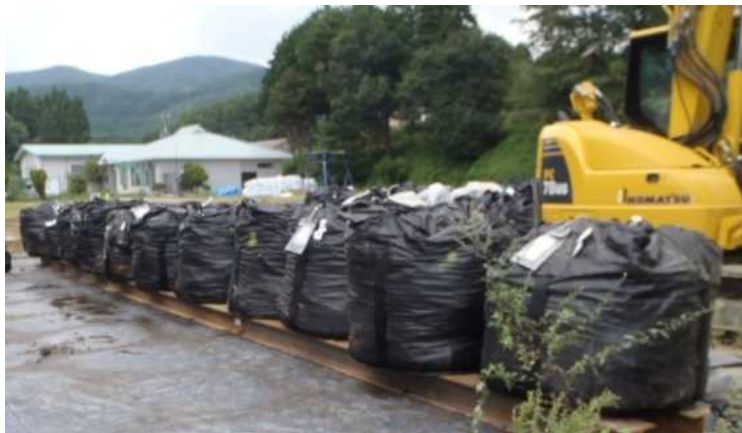
図 2.1.3-6 水切り架台の設置状況の例
