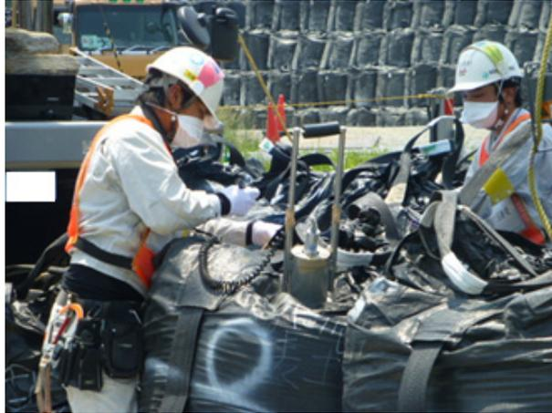
図 2.1.3-8 容器の表面線量率の測定状況
