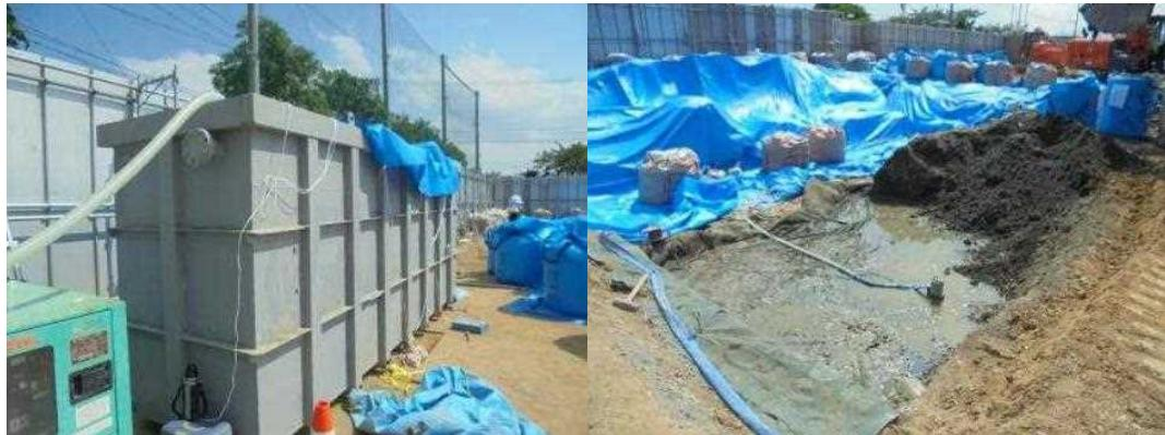
図 2.1.3-5 発生する濁水や浸出水等の回収と処理
