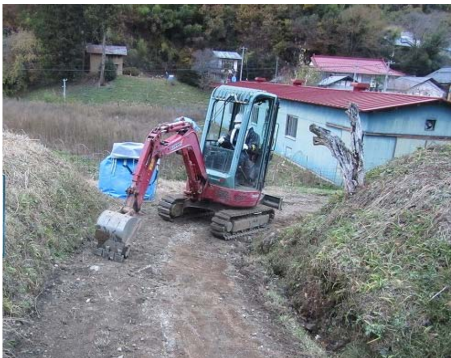
図 2-39 未舗装道路の除染の例（削り取り）
