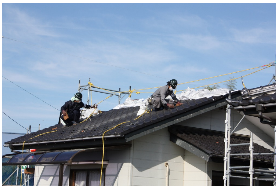
図2-9 屋根の瓦の除染の例（拭き取り）
