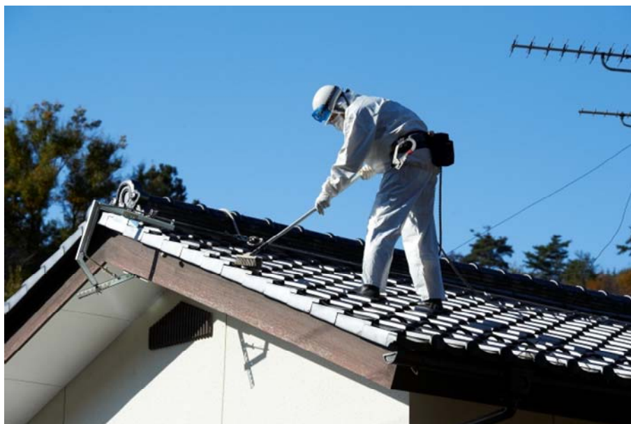
図 2-10 屋根の瓦の除染の例（洗浄）
