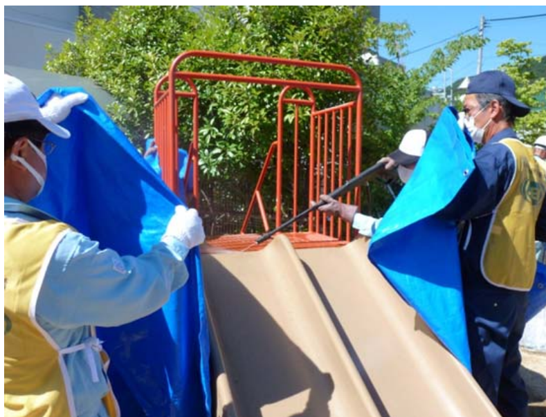
図 2-17 遊具の除染の例（高圧水洗浄）
