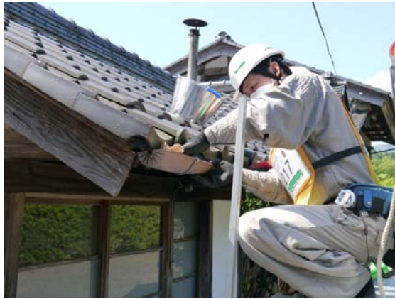
図 2-12 雨樋の除染の例（拭き取り）
