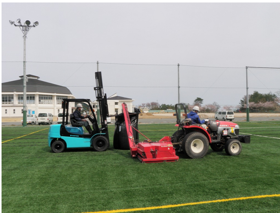
図 2-51 人工芝の充填材の除去の例
