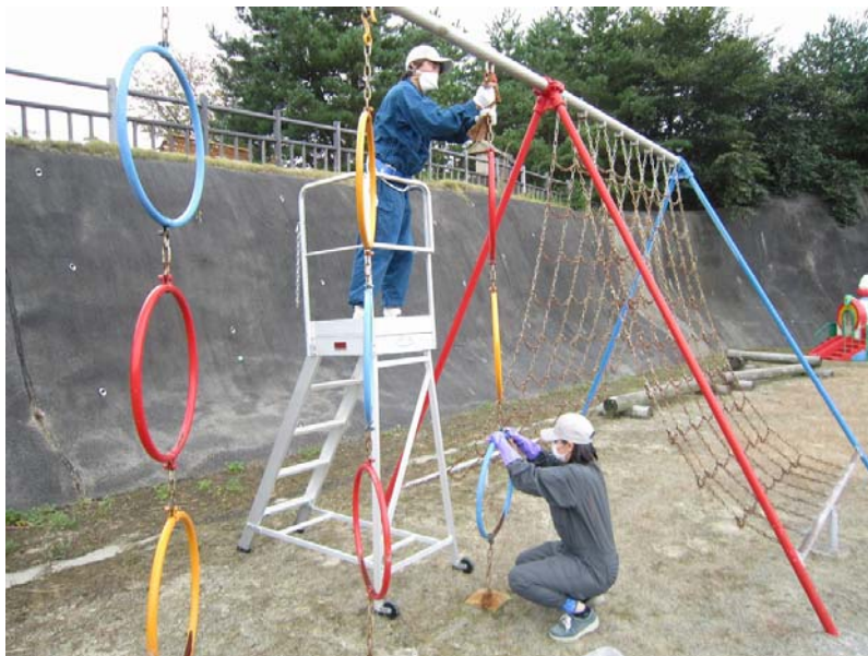
図 2-16 遊具の除染の例（拭き取り）
