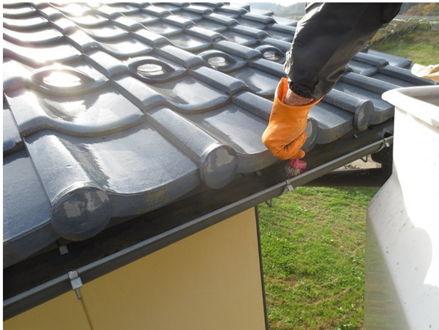
図 2-13 雨樋の除染の例（ブラシ洗浄）
