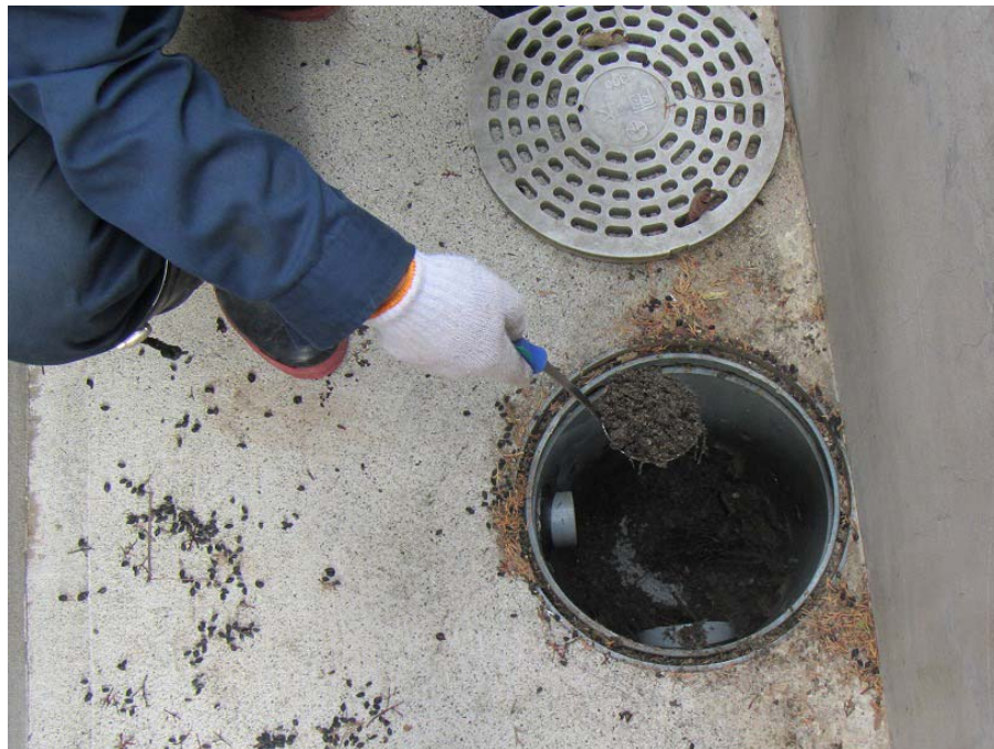
図 2-24 雨水枡の除染の例（堆積物の除去）
