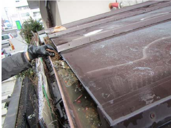
図 2-12 雨樋の除染の例（拭き取り）
