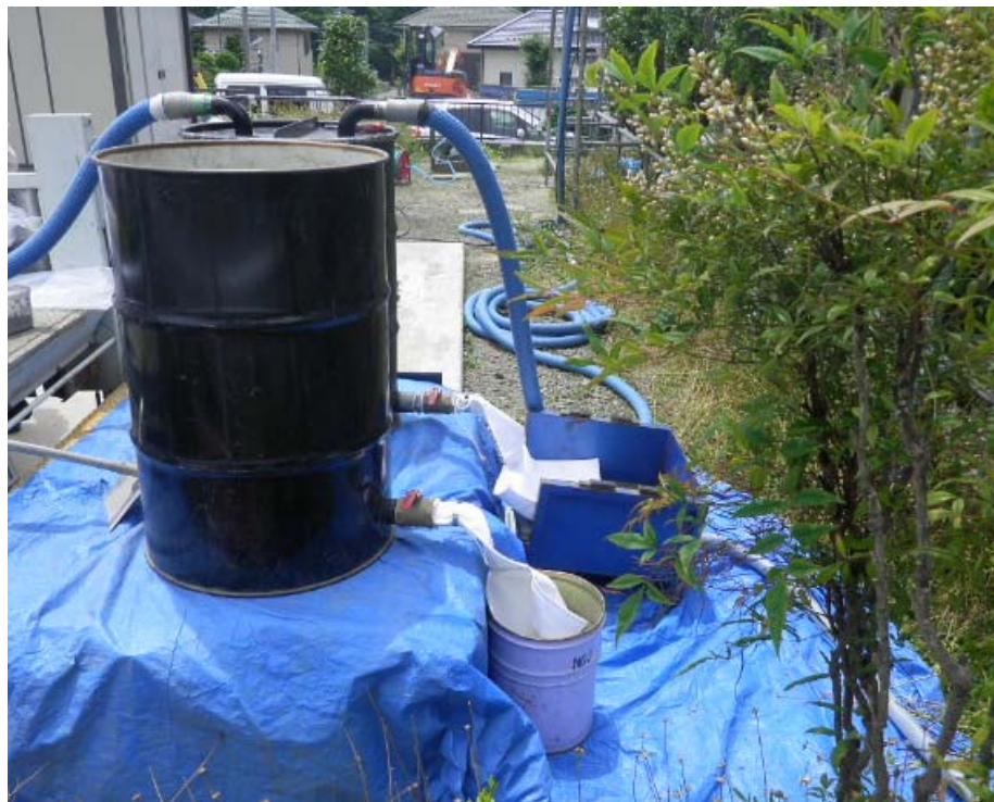
図 2-32 排水の処理の例（水槽を用いた沈殿処理）
