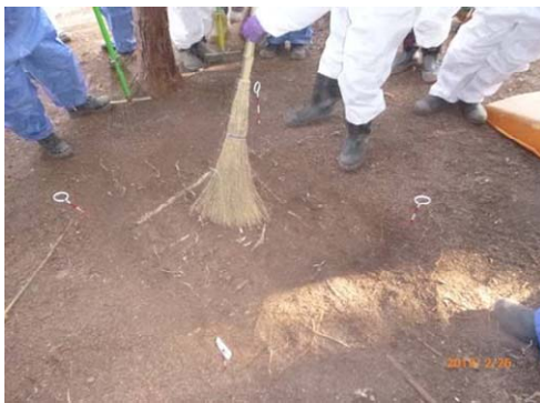
堆積有機物の除去の後に、 竹箒*により残さを除去。 *先端20cm程度をカットし弾力性を確保したもの。
