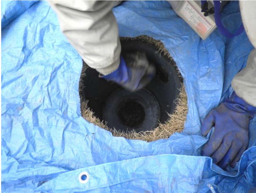
図 2-27 雨水枡の除染の例（スポンジ洗浄）
