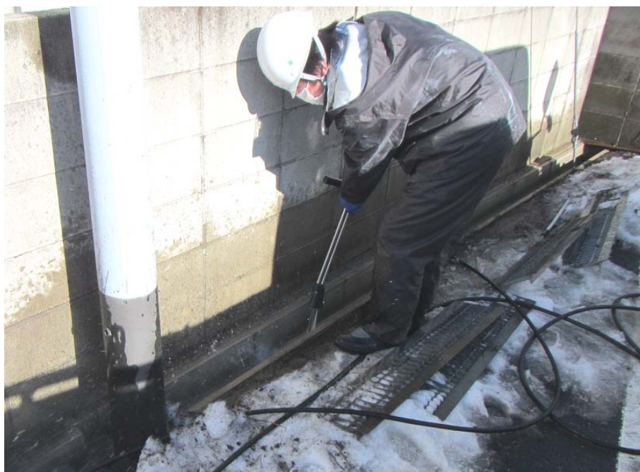
図 2-26 側溝の除染の例（高圧水洗浄）
