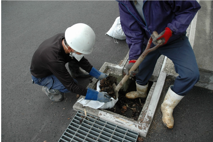
図 2-23 側溝の除染の例（堆積物の除去）
