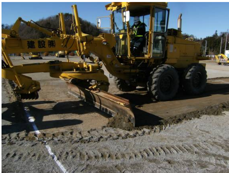
図 2-50 校庭の除染の例（表土の削り取り）
