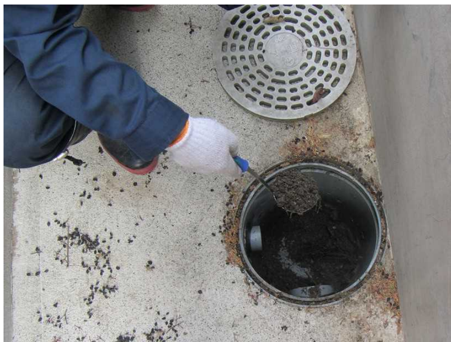
図 2-24 雨水枡の除染の例（堆積物の除去）
