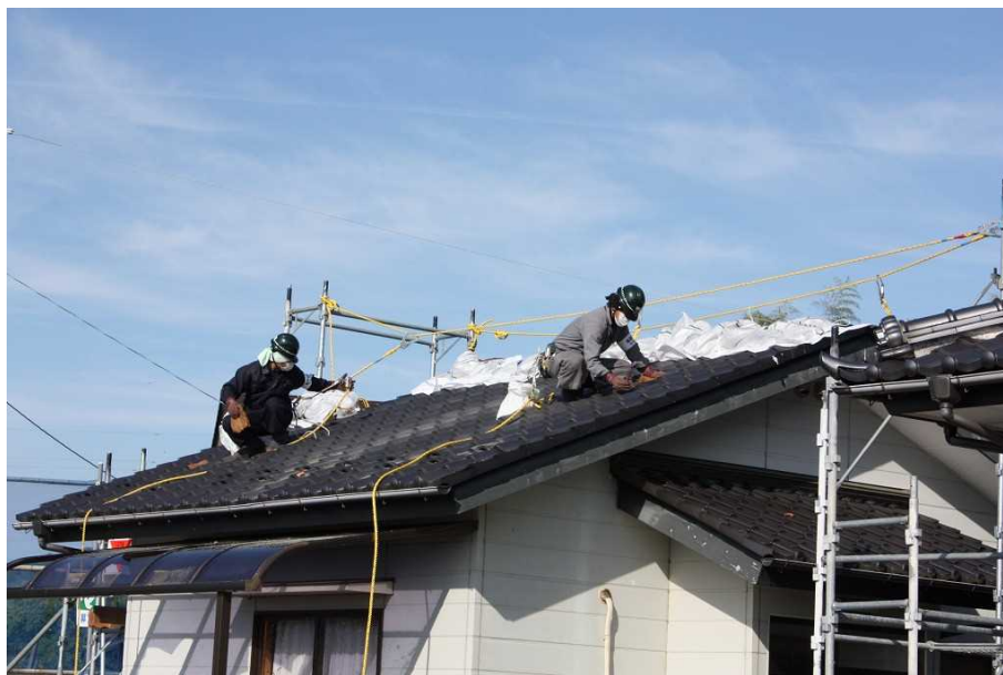
図2-9 屋根の瓦の除染の例（拭き取り）
