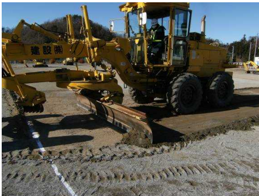
図 2-50 校庭の除染の例（表土の削り取り）
