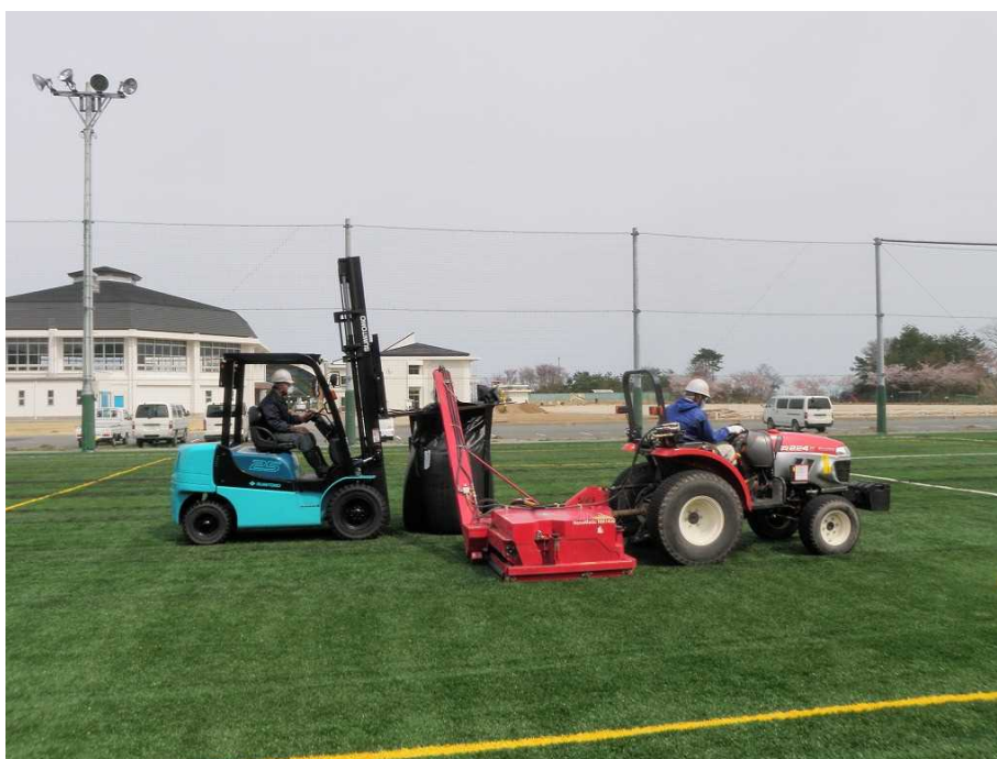
図 2-51 人工芝の充填材の除去の例
