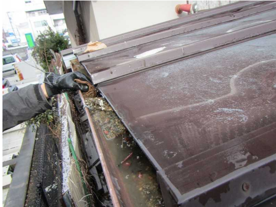
図 2-12 雨樋の除染の例（拭き取り）
