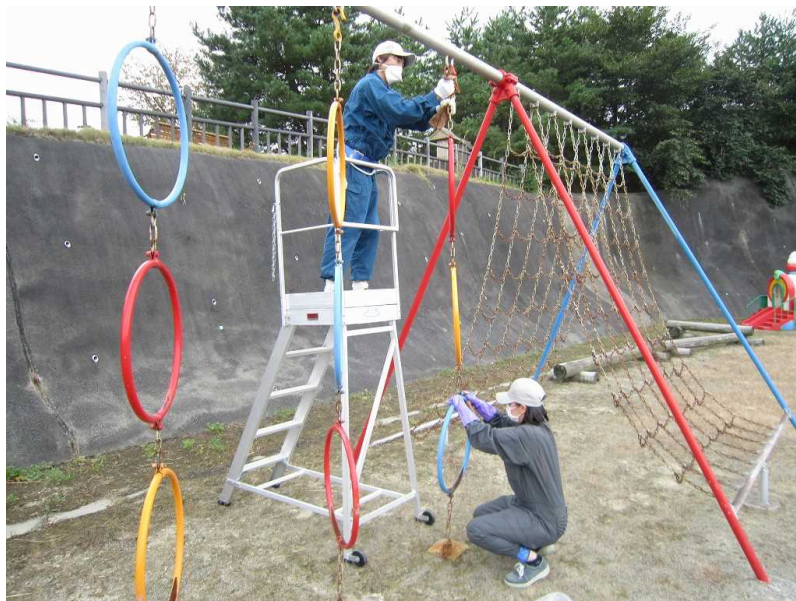
図 2-16 遊具の除染の例（拭き取り）
