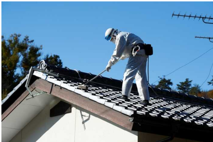
図 2-10 屋根の瓦の除染の例（洗浄）
