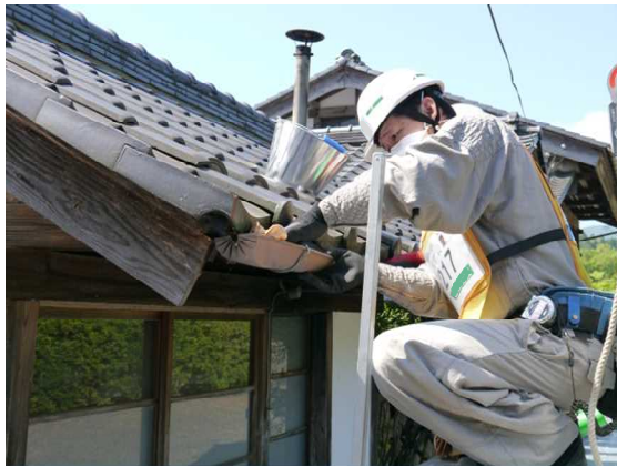
図 2-12 雨樋の除染の例（拭き取り）
