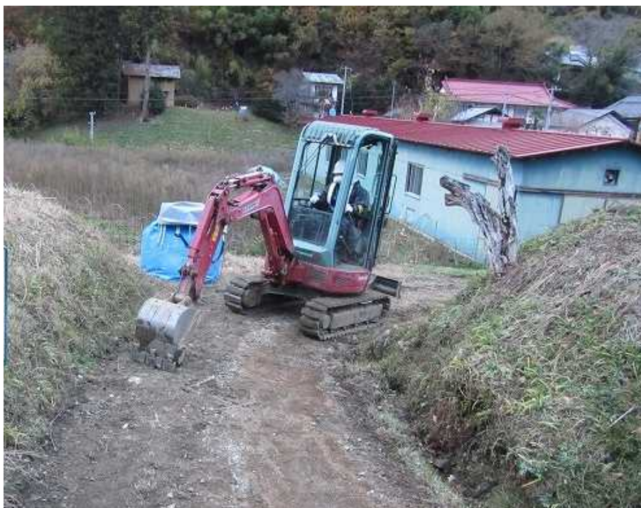
図 2-39 未舗装道路の除染の例（削り取り）
