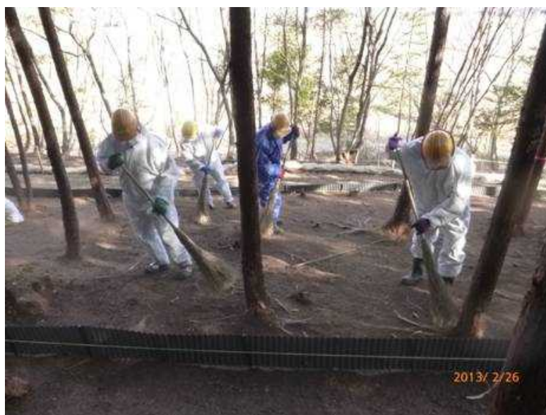
図 2-66 森林の除染の例（堆積有機物残さ除去）
