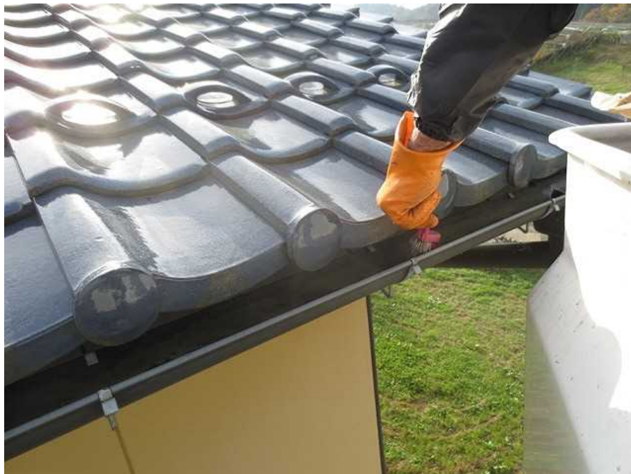
図 2-13 雨樋の除染の例（ブラシ洗浄）
