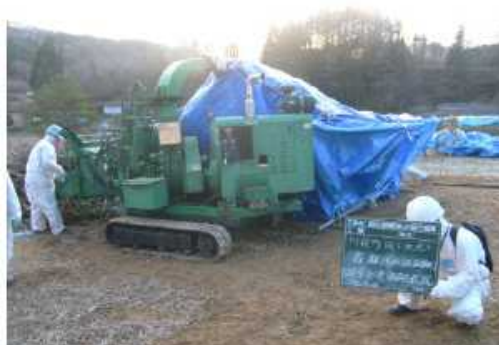
図 2-26 破碎機（チップパー）による減容化（例）
