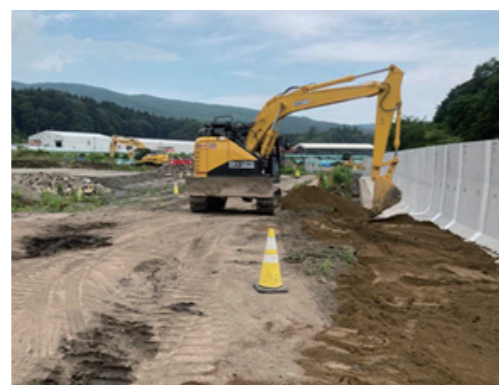
盛土の状況(2工区)
