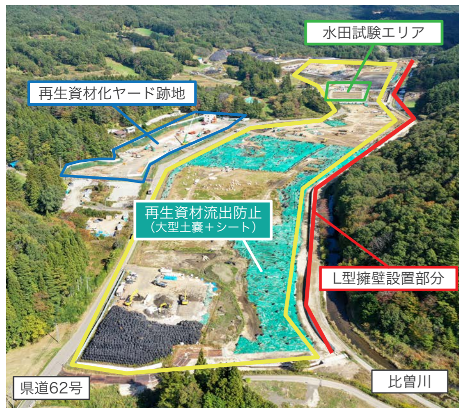
2工区全域の現状(令和4年10月撮影)
