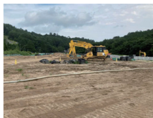
盛土の状況(3工区)
