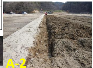
額縁明渠 (区画周辺排水溝) (4月12日)
