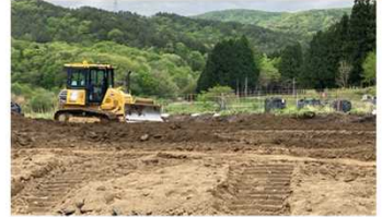
再生資材からの被ばく線量低減のため、盛土の上に50cm以上覆土します。覆土 (山砂) は20mm以下のものを使用します。
