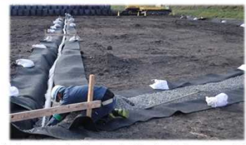
盛土の安定性を確保するために地下水・湧水を集水する排水管を設置します。
