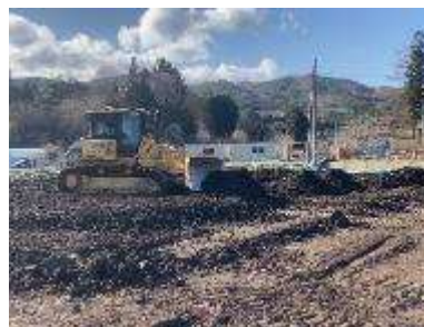
◆盛土造成(3月28日~5月13日)
