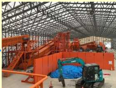
大テント内状況
