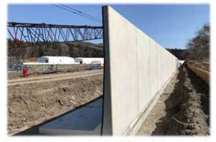
農地盛土のかさ上げに伴い、自然災害等で再生資材が流出しないように土留めの擁壁を設置します。
