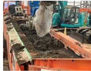
破袋後の土壌の取り出し
