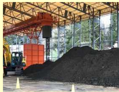
再生資材一時置場状況
