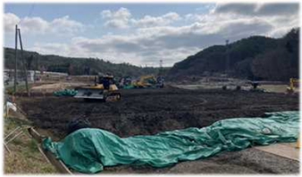
再生資材を重機で1層あたり30cm程度に敷均し転圧して盛土します。
