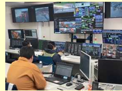
集中監視室内状況
