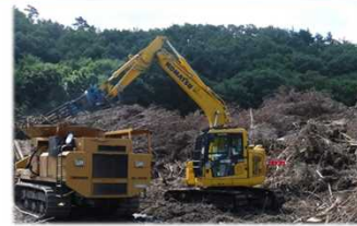
盛土による沈下等を抑えるために、腐植物を除去します。
