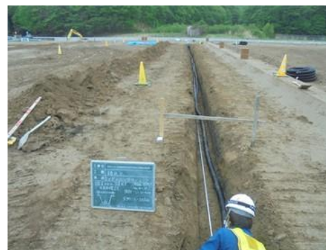
②暗渠排水設置状況
