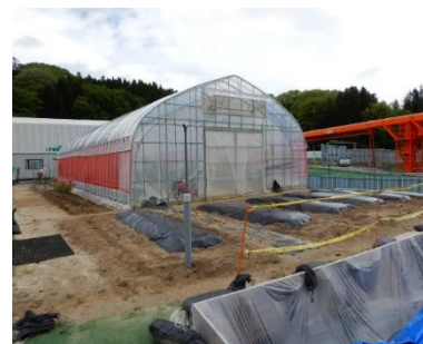
覆土区画全景 (5月18日)
