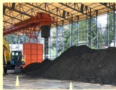
再生資材一時置場状況
