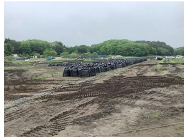
準備工（腐植物除去）状況 (R3.5.15撮影)
