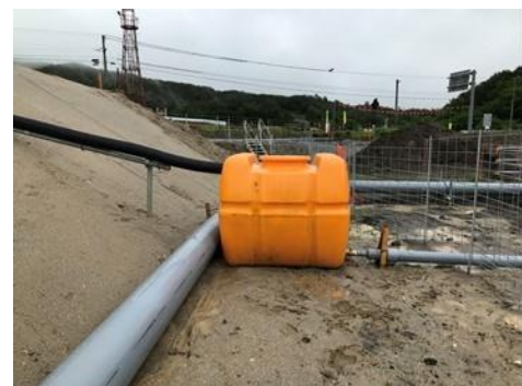
④集水タンク・排水管設置状況
