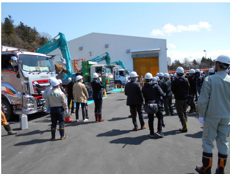
大型土のう袋を荷下ろししている現場の見学の様子
