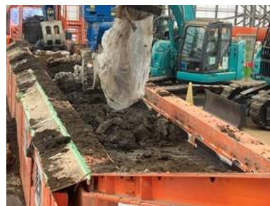
破袋後の土壌の取り出し
