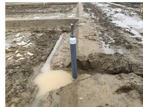
③水閘・畦畔設置状況
