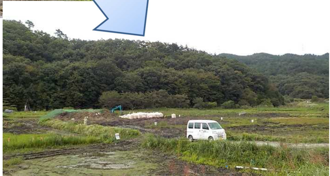
準備工（除草、樹木伐採工） 完了後(R2.10.1撮影)
