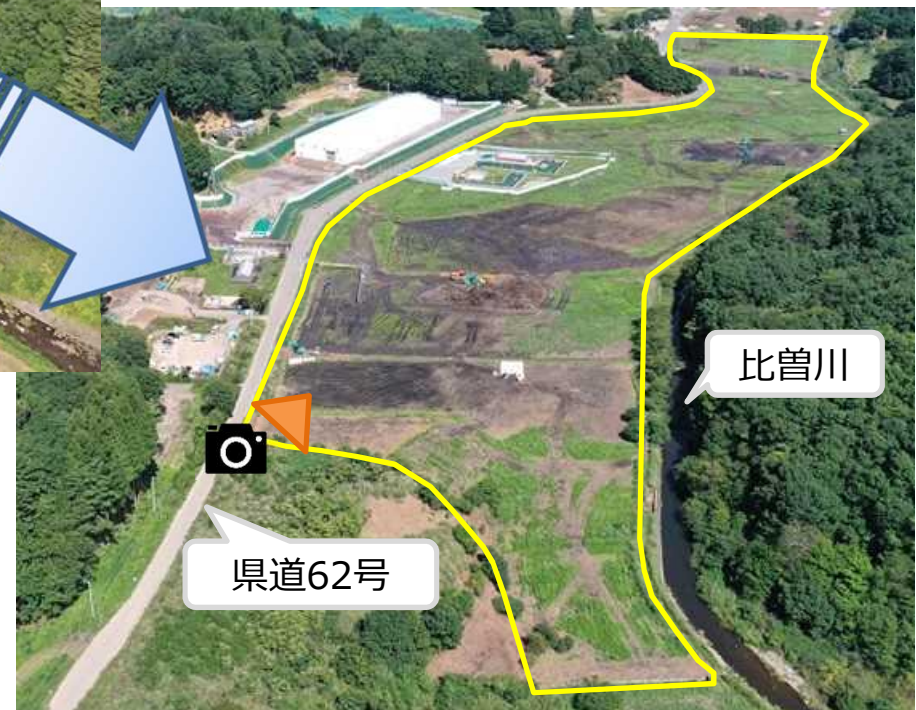
準備工（除草、樹木伐採工） 完了後(R2.9.8撮影)
