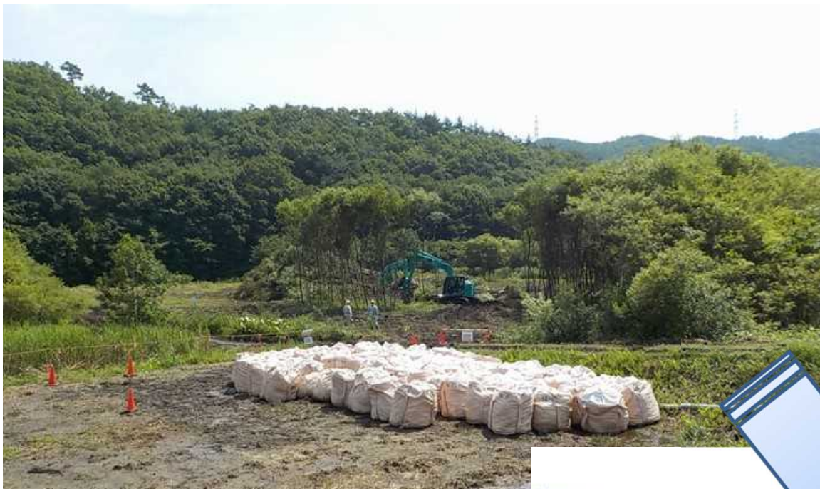
準備工（除草、樹木伐採工） 施工中(R2.8.6撮影)
