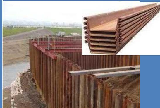
鉄製の鋼矢板を地中に埋め込み、壁を作る工法。
