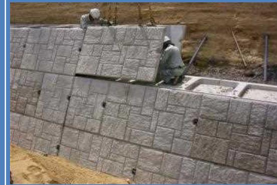
工場で作製した大型のブロックを積み重ね、その間にセメント等を充填して堅固にする工法。
