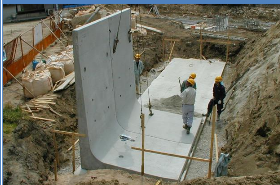
プレキャストL型擁壁工法
