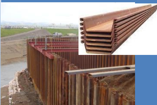
鋼矢板遮断壁 入工法
