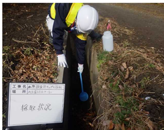
側溝からの採取状況
