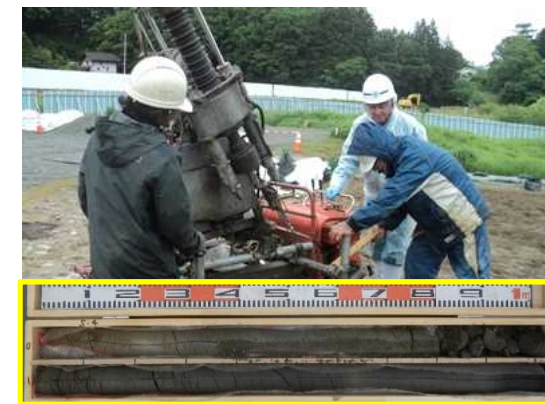
3.土壌サンプルリグ・パイプ挿入 (6月12～14日)
