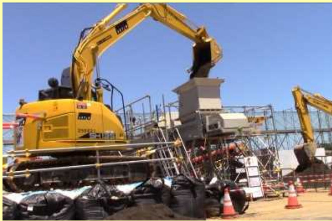
ホッパーへの除去土壌投入
