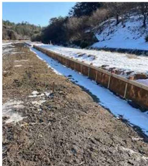
土砂流出防止柵設置状況
