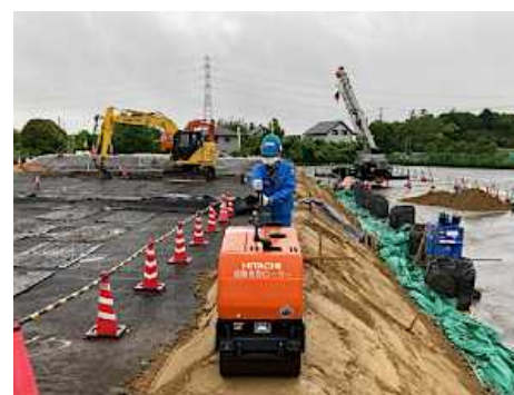
路体盛土覆土転圧状況
