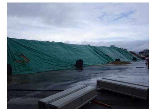
法面部シート養生設置状況
