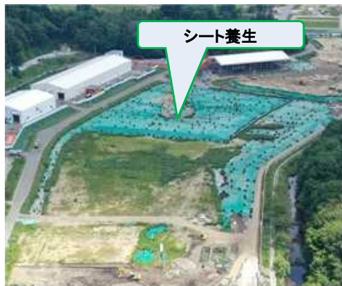
シート養生状況
