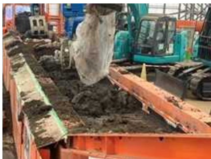
破袋後の土壌の取り出し
