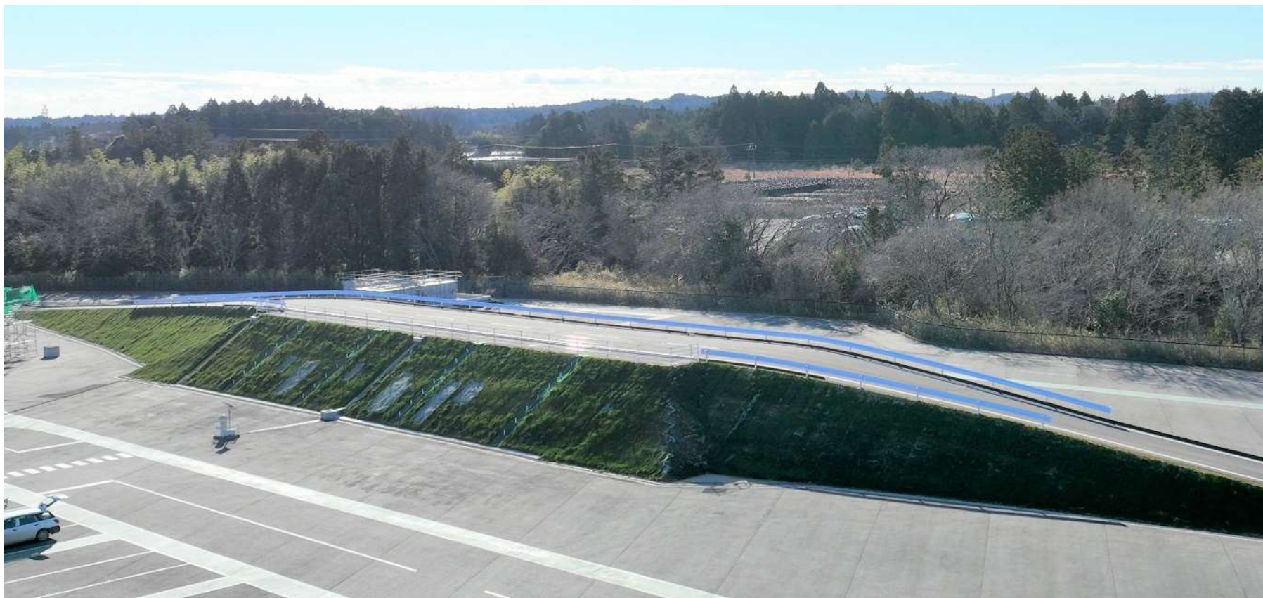
竣工後(2023年12月25日_撮影)
