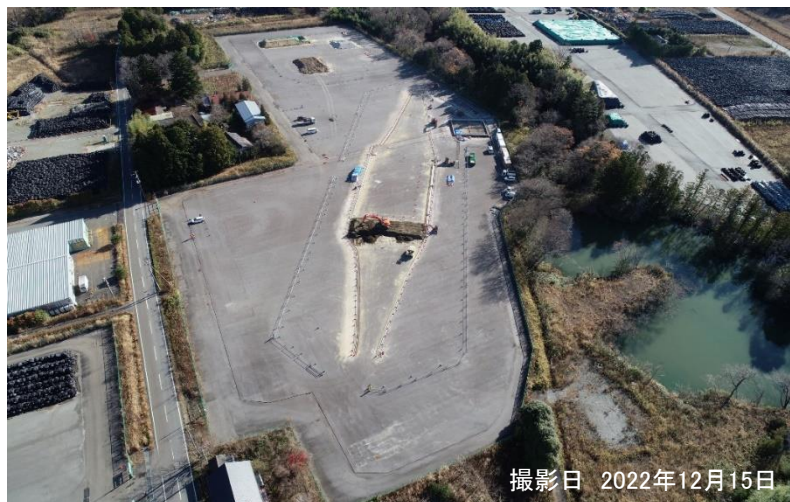
準備工事(盛土工(スロープ部))
