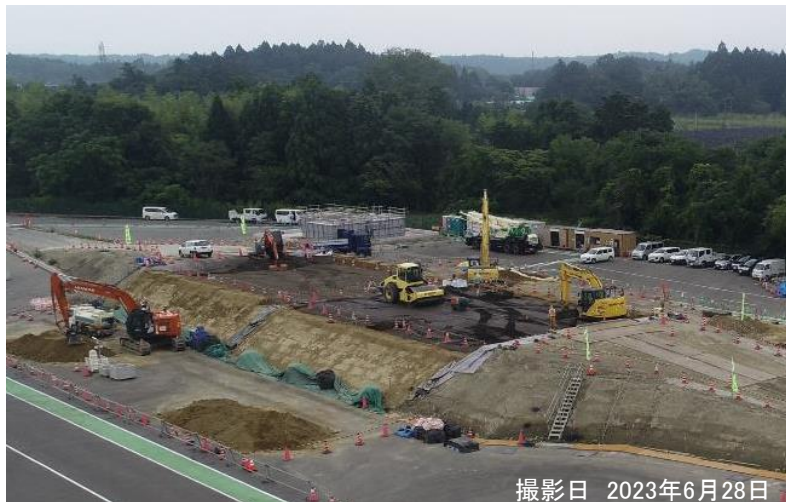
路体盛土工(路体9層目)
