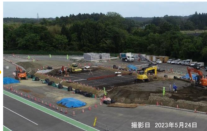
路体盛土工(2層目)
