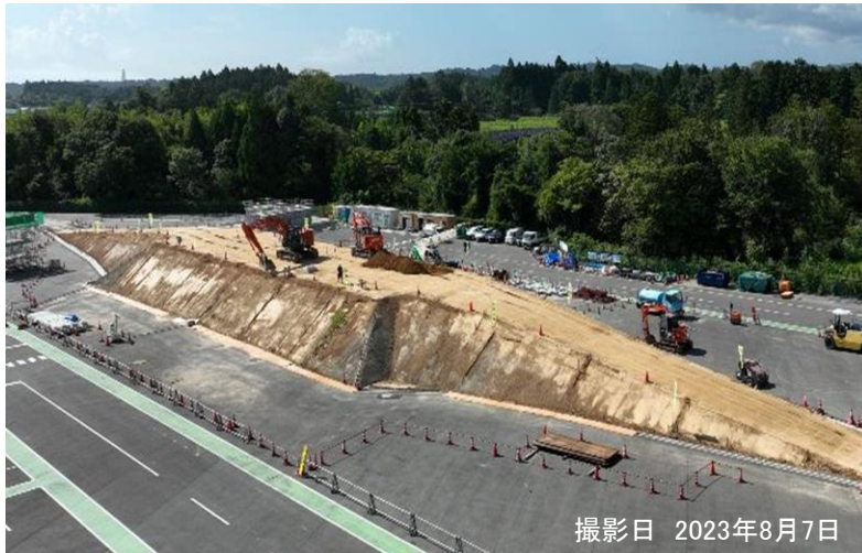
路床盛土工(覆土)
