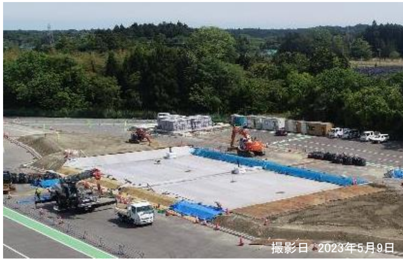
浸透水処理工(盛土底盤部)
