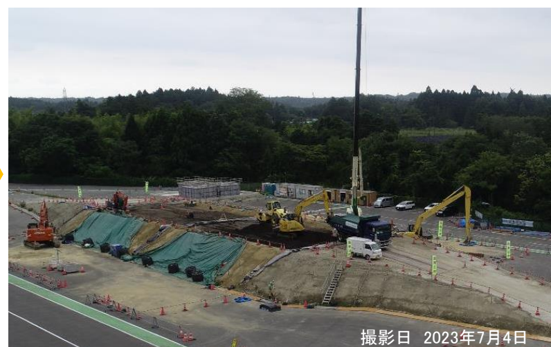
路体盛土工(路体11層目)
