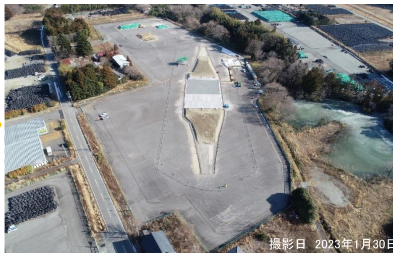
準備工事(盛土工(スロープ部))
