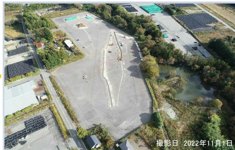
準備工事(排水工)
