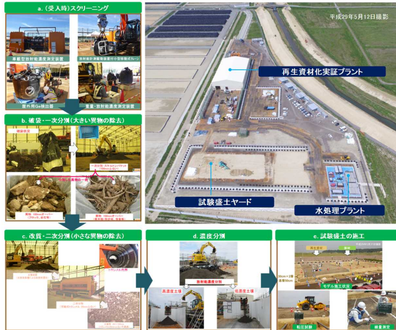
実証ヤード(約2ha)の全景と各試験状況
