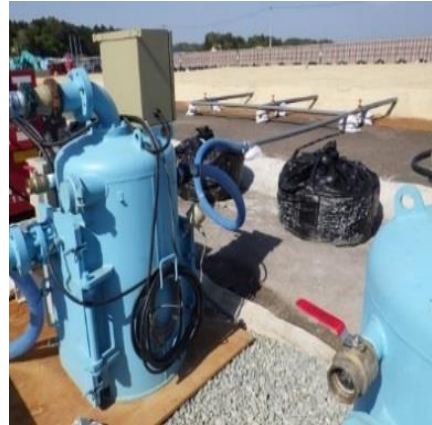
浸透水の集水設備の概観
