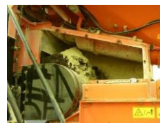
改質機の土砂詰りの状況
