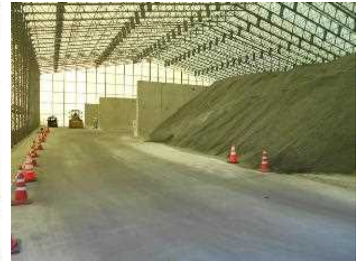
廃棄物貯蔵施設（双葉 1 工区） （スラグの貯蔵）
