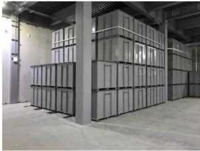
廃棄物貯蔵施設（大熊 1 工区） （ばいじんの貯蔵）
