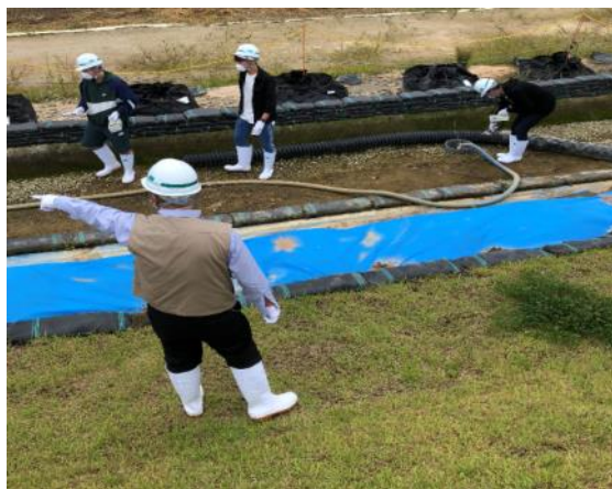
再生利用実証事業施設
