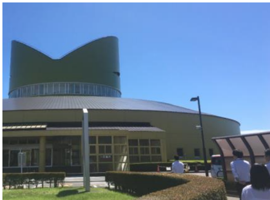
JNFL低レベル放射性廃棄物埋設センター
