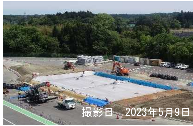
浸透水処理工（盛土底盤部）
