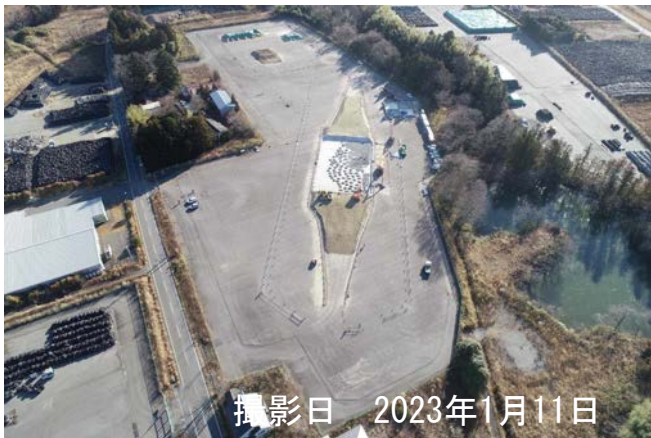
準備工事（盛土工（スロ-ﾌﾟ部））
