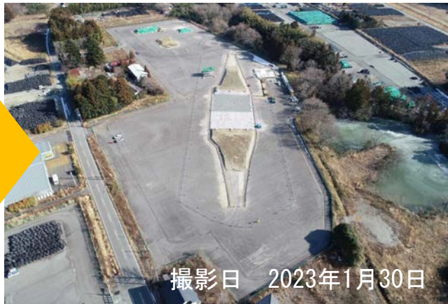
準備工事（盛土工（スロ-ﾌﾟ部））
