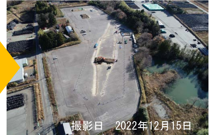
準備工事（盛土工（スロ-ﾌﾟ部））
