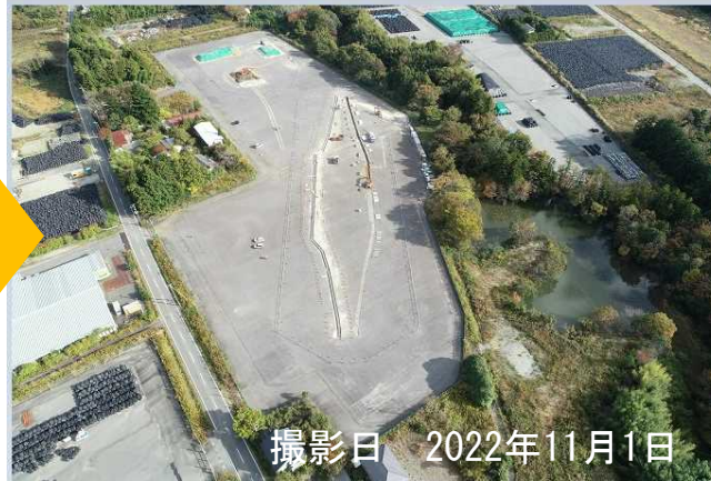
準備工事（排水工）
