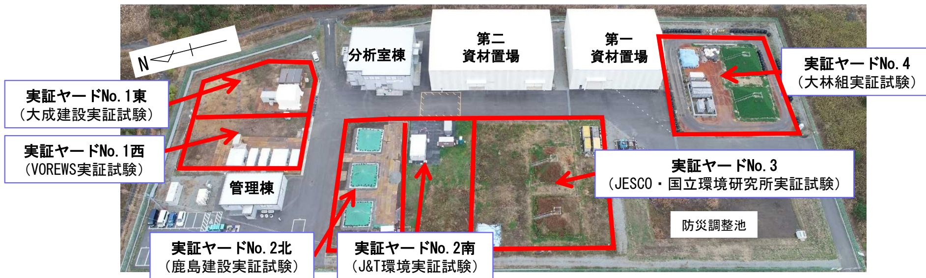
ドローンによる技術実証フィールド全景（2022年12月1日時点）
