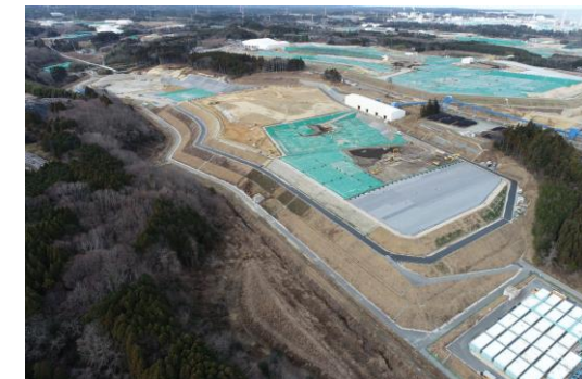
土壌貯蔵施設(大熊③工区)
