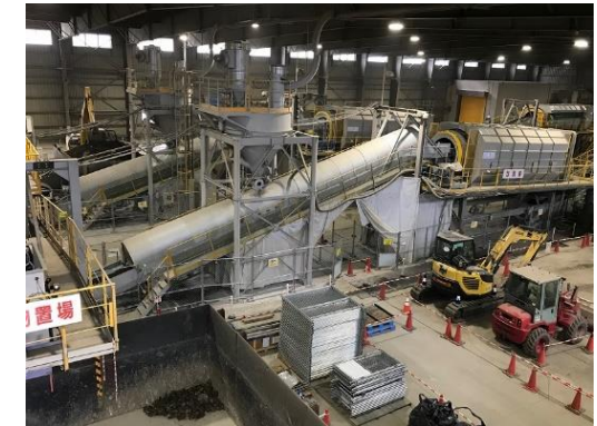
受入・分別施設(大熊①工区)
