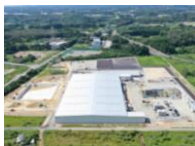
不燃性廃棄物再資源化施設
