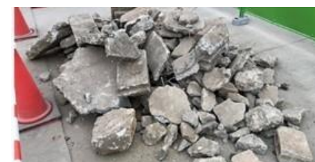
コンクリートガラ
