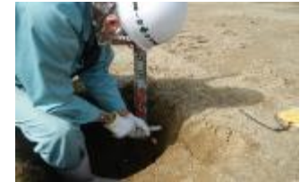
山中式硬度計による硬度確認
