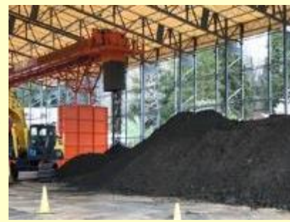
再生資材一時置場状況
