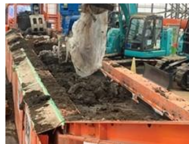
破袋後の土壌の取り出し
