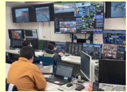
集中監視室内状況
