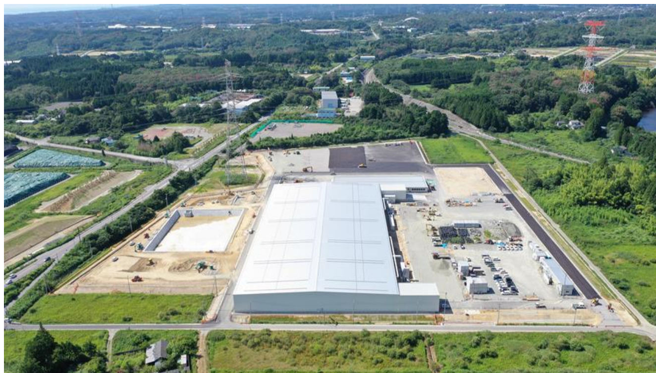
不燃性廃棄物の再資源化施設 外観 写真2020年8月13日撮影
