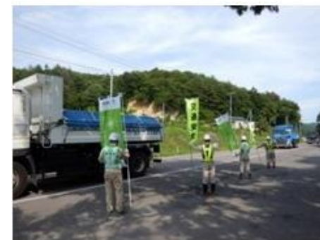
車両走行状況の現場確認(国道288号)
