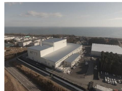
大熊町の仮設焼却施設
