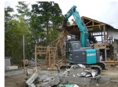
解体した被災家屋の基礎
