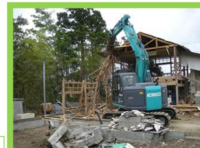
被災家屋等の解体
