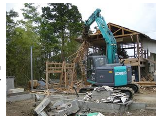
被災家屋等の解体
