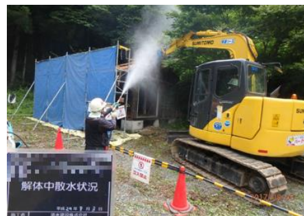
被災家屋等の解体の様子
