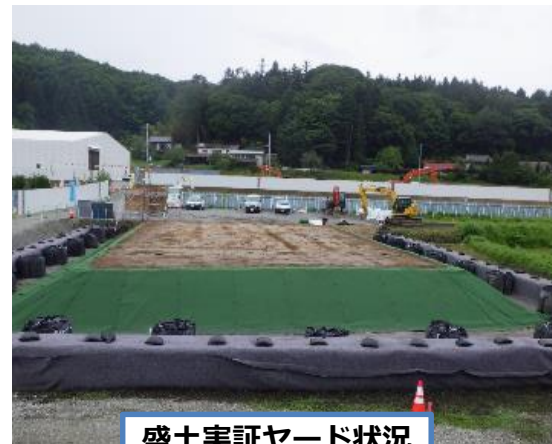
盛土実証ヤード状況
