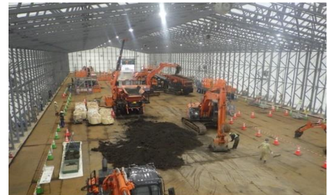
再生資材化プラント
