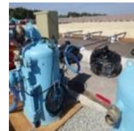
浸透水の集水設備の概観
