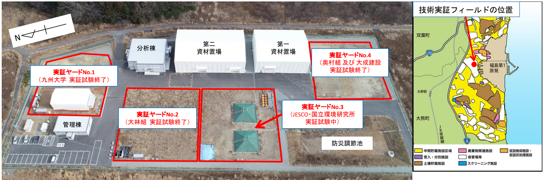
技術実証フィールドの全景（2021年2月3日撮影）
