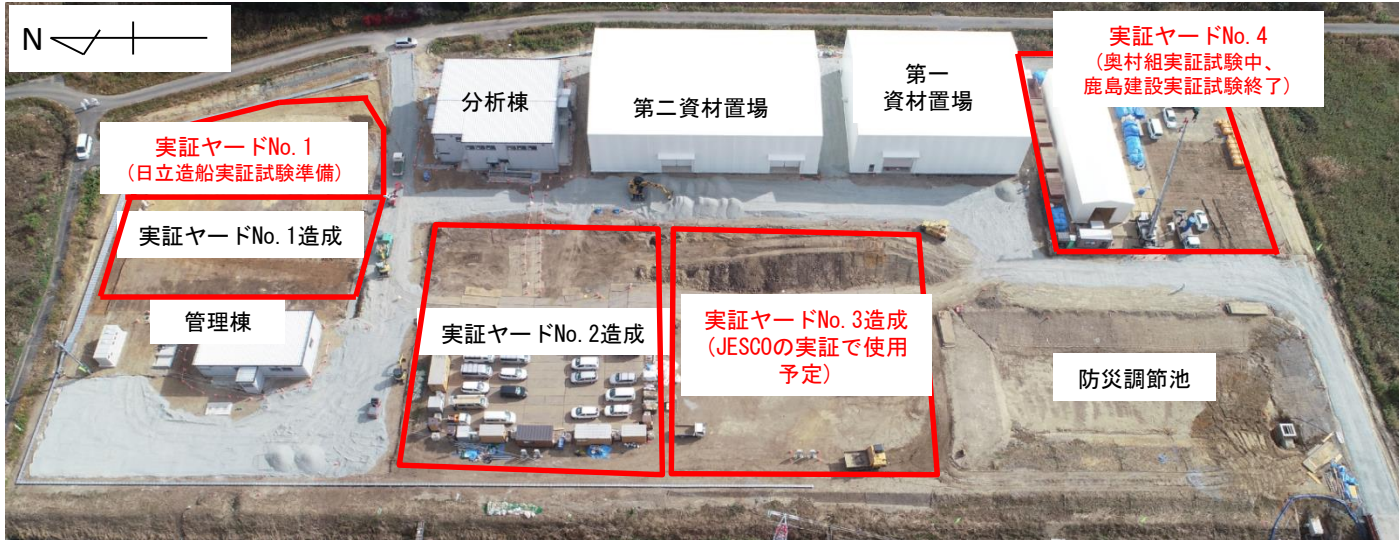
ドローンによる技術実証フィールド全景（11月22日時点）
