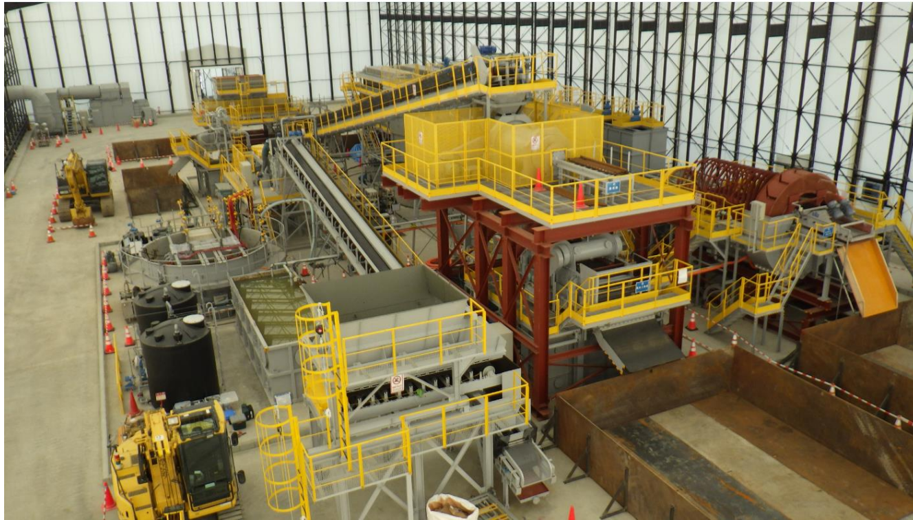
テント内全景
